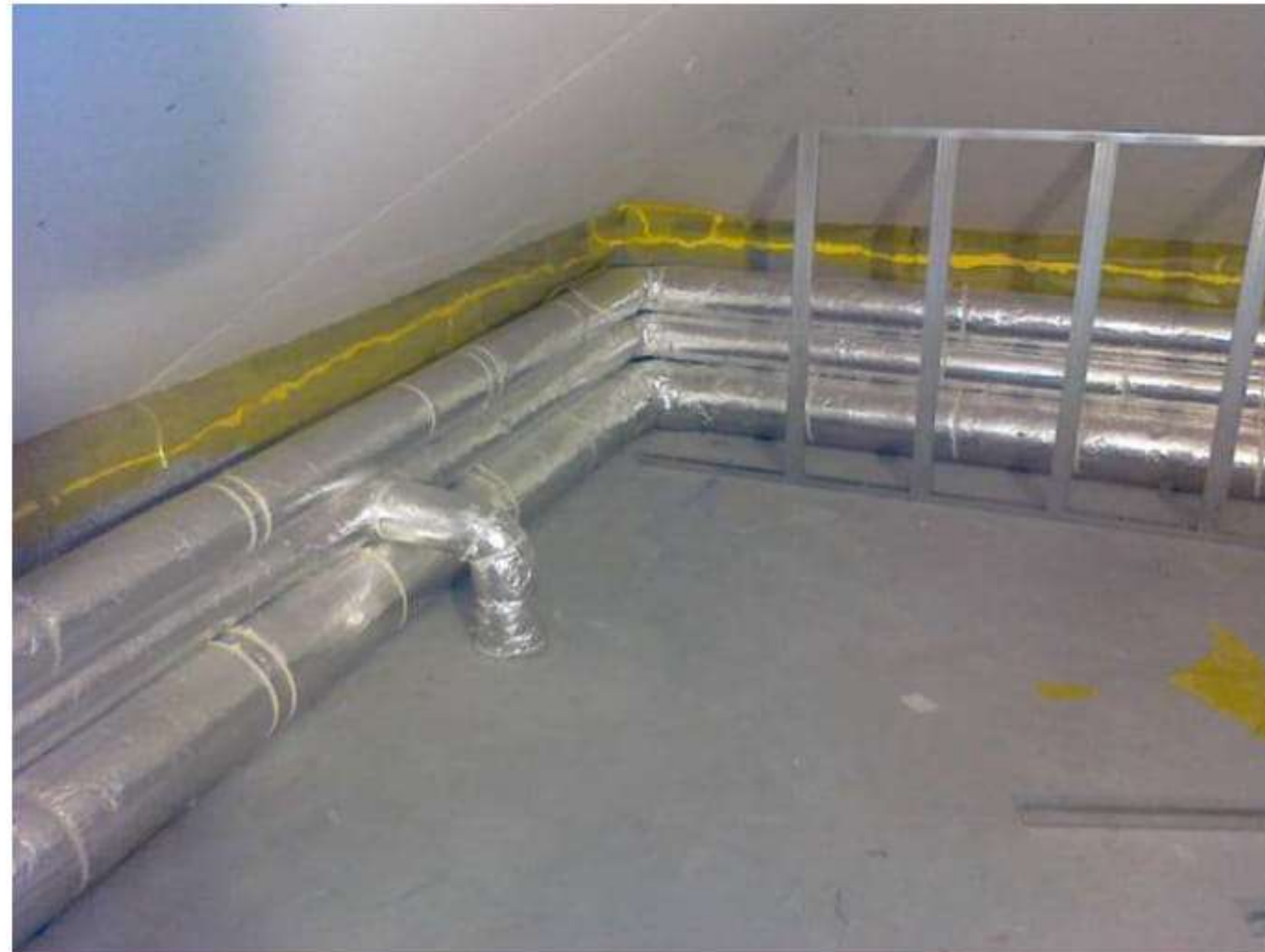
Instalacja rekuperacji zbudowana z kanałów wentylacyjnych stalowych przygotowana do zabudowania w ścianie kolankowej pomieszczenia na poddaszu.
