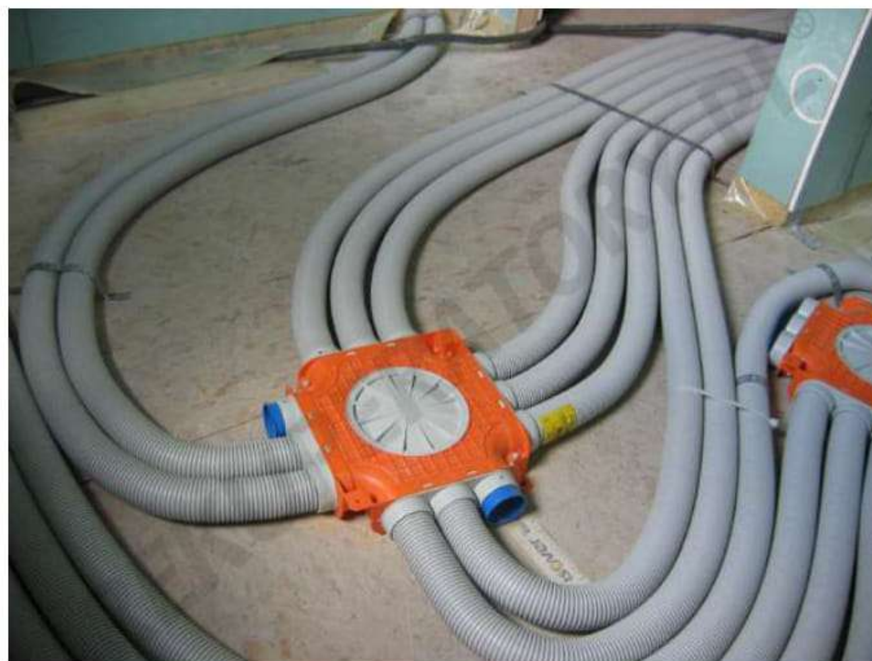
Instalacja rekuperacji wykonana z systemu z tworzywa przygotowana do zalania w warstwie posadzki.
