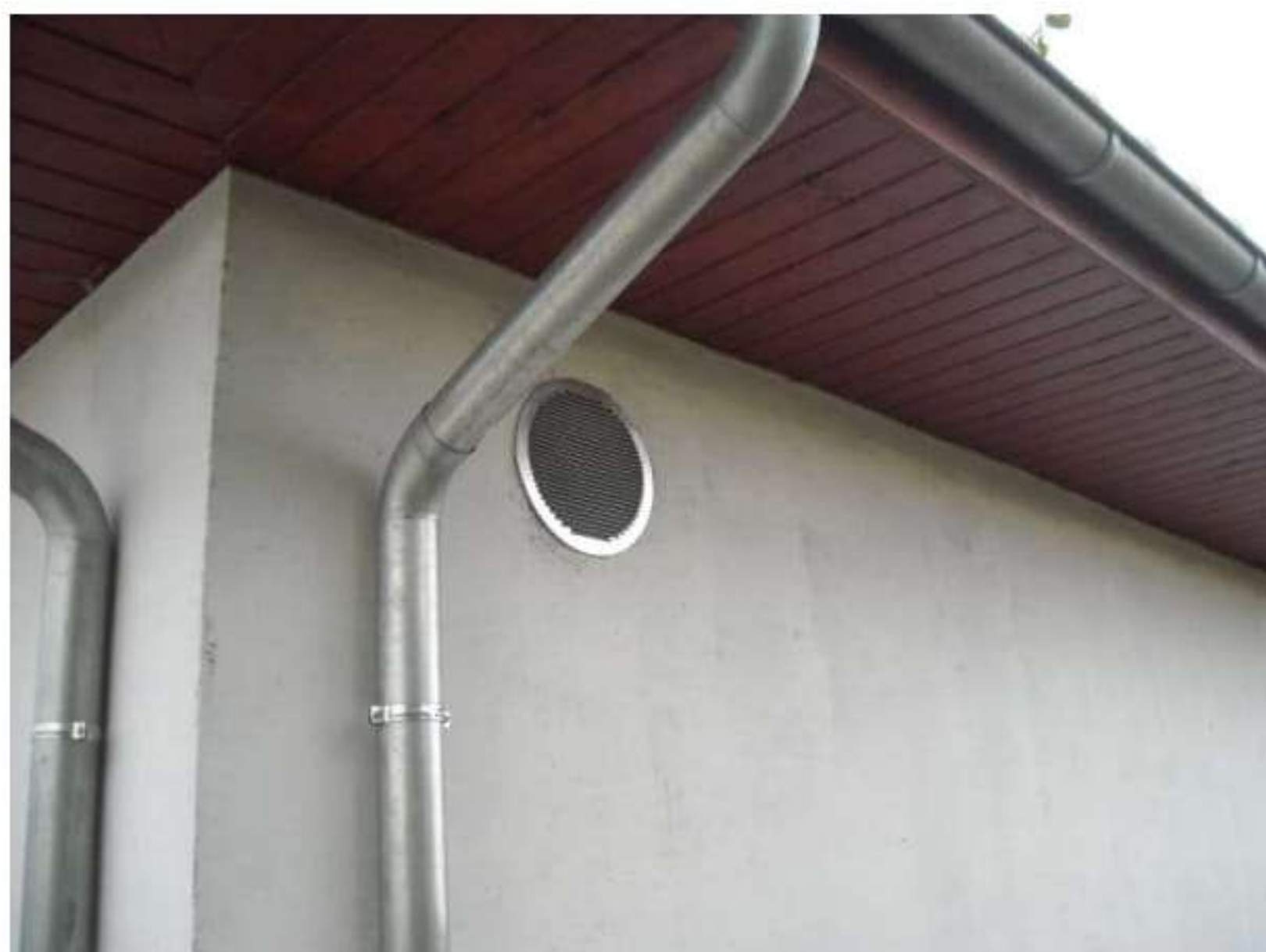
Czerpnia w budynkach z wentylacją mechaniczną.
