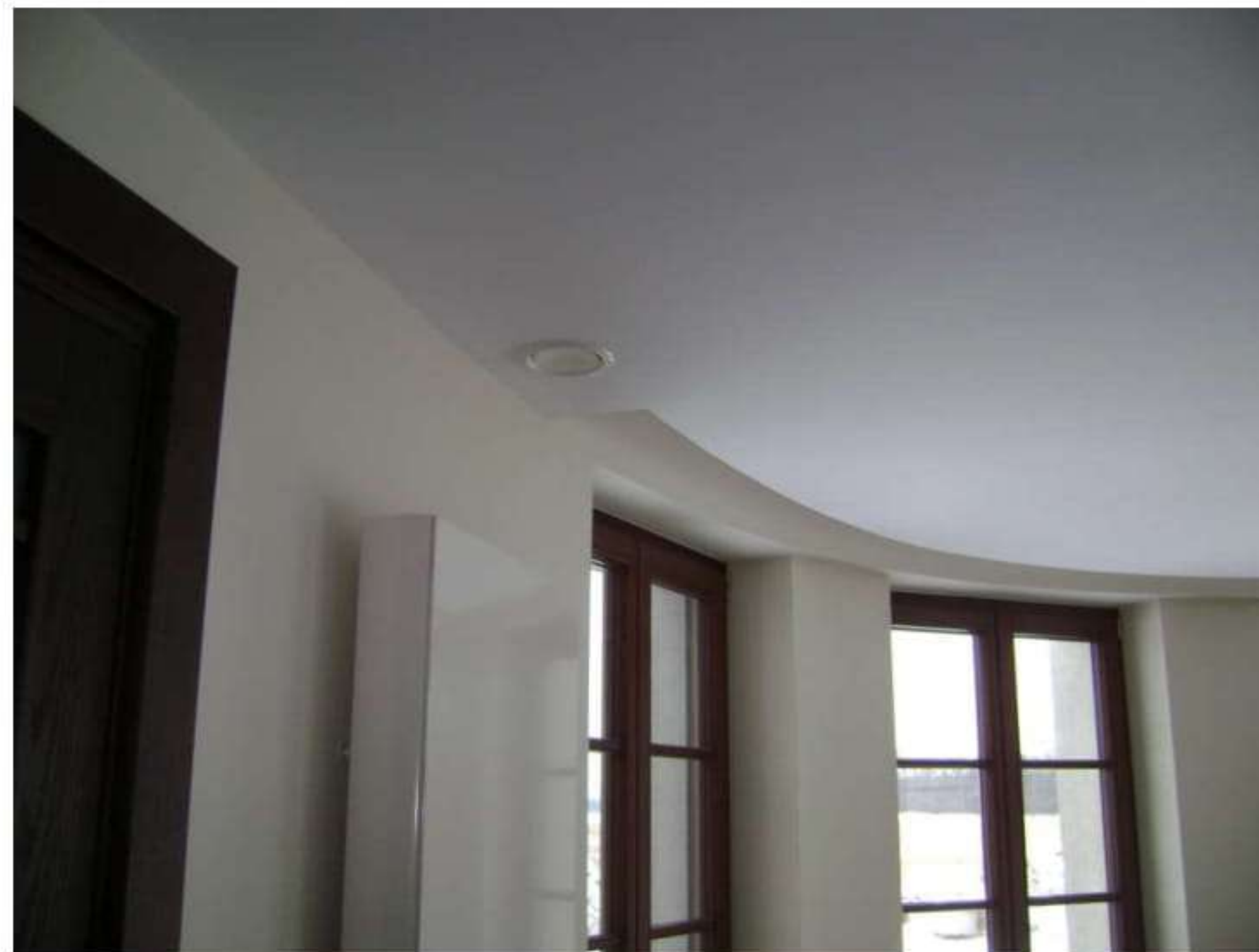
Anemostat nawiewny na suficie w pomieszczeniu z wentylacją mechaniczną.
